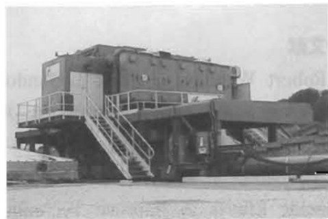
アスファルト固化廃棄体回収筐体 (ERFB)
