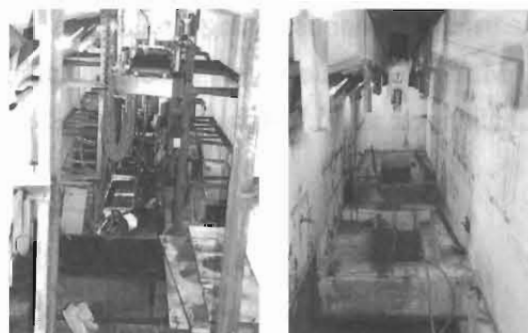
緩衝貯蔵セルの解体前(左、遠隔操作装置付)と解体後(右、装置なし)
